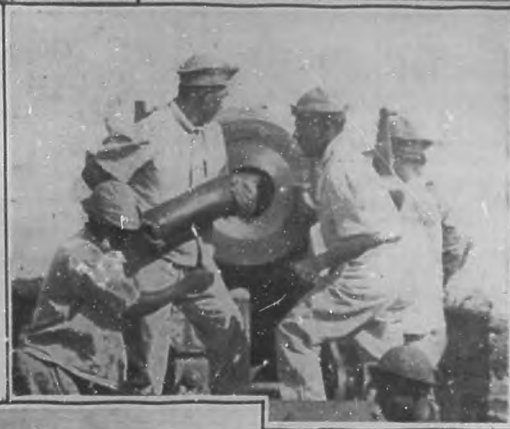
El proceso de carga es relativamente rápido en los Oróñez. Cada pieza puede cargar una bala de 50 libras cada 3 minutos a 8000 metros de distancia.
