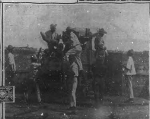
Limpio el cañón y colocado el proyectil, los artilleros introducen en la recámara la carga de piroxilina.
